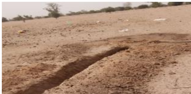
Photo 69 : tranchée destinée à la pose de conduite AEP sur le tracé
