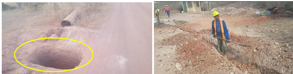
Photo 38: exemple de fouille et de tranchée non balisées/projet de ligne électrique (Source : Infoges, Novembre 2021, Décembre 2023)
