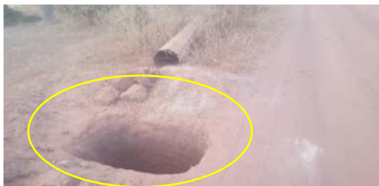
Photo 16: exemple de fouille non balisée/projet de ligne électrique (Source : Ankh, Novembre 2018)
