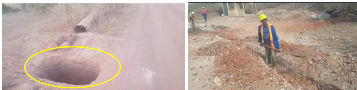
Photo 92: exemple de fouille et de tranchée non balisées/projet de ligne électrique (Source : Ankh, Novembre 2018, Décembre 2023)
