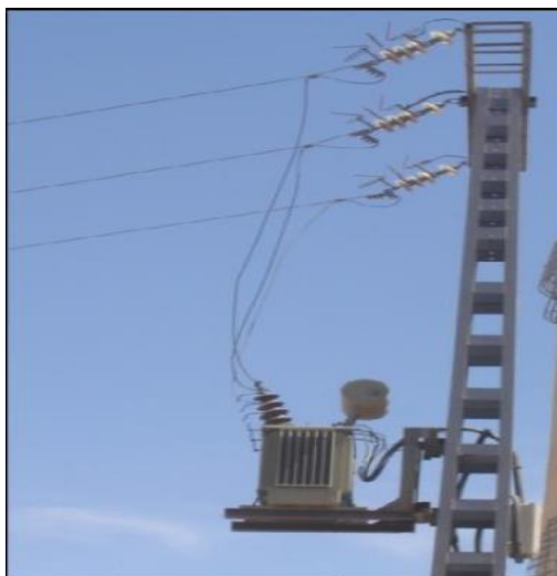
Photo 1 : Poste haut de poteau H61 (illustration) 14
